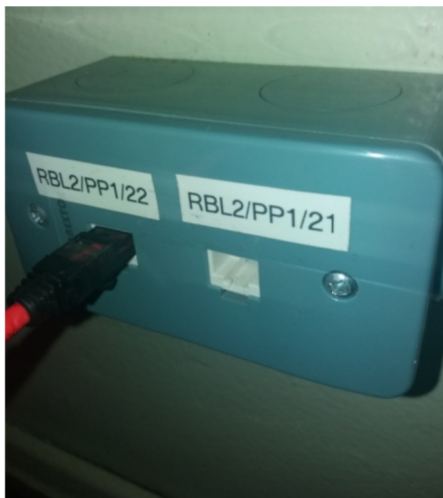
Fig. 7: Ponto de rede x2 devidamente identificado.
